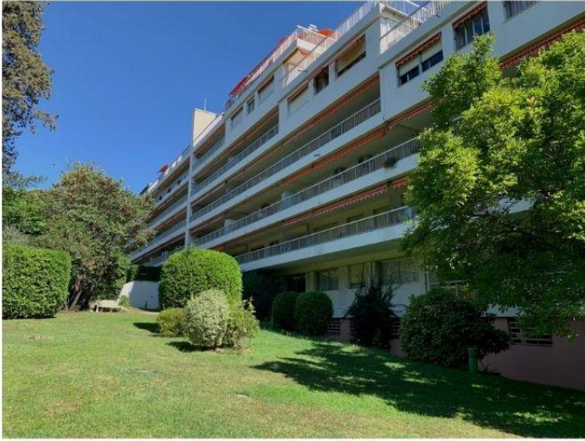
La façade ouest
